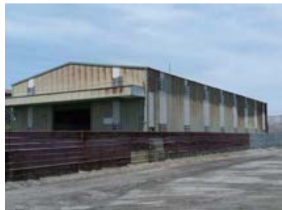
外觀鏽蝕嚴重，屋頂烤漆板需更換
